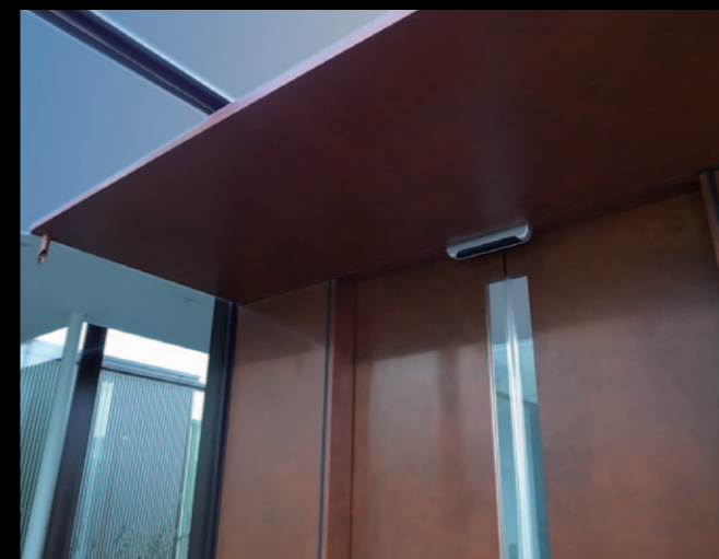
外部の扉・庇をコールテン鋼風に
