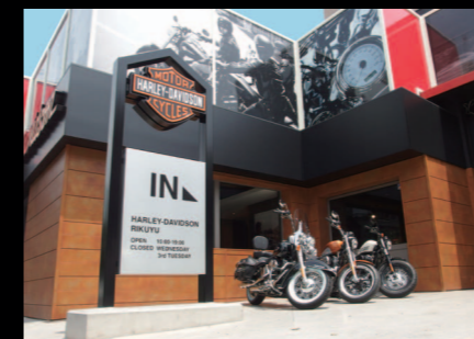
外部金属パネルに赤サビ塗装 SR-009
