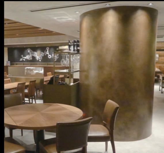
ボード下地丸柱に真鍮古美色塗装 1
