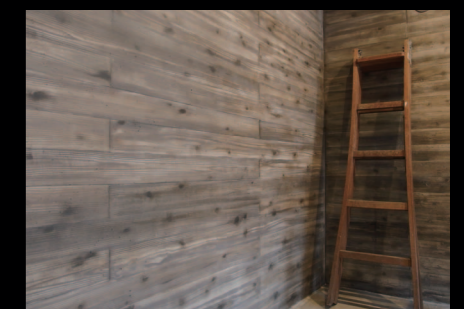
コンクリート杉板型枠風仕上げ
