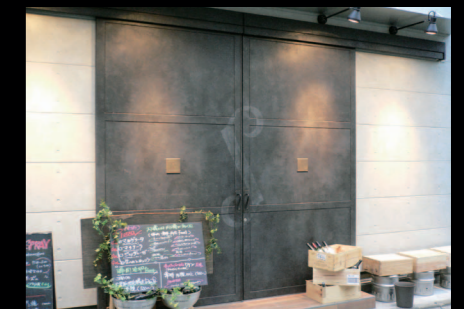
重厚な鉄扉にサビ塗装とステンシル
