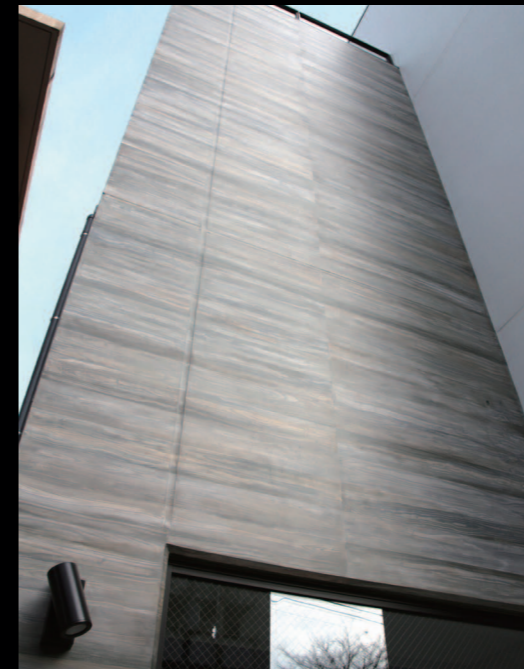
杉板本実型枠コンクリートを塗装で再現
