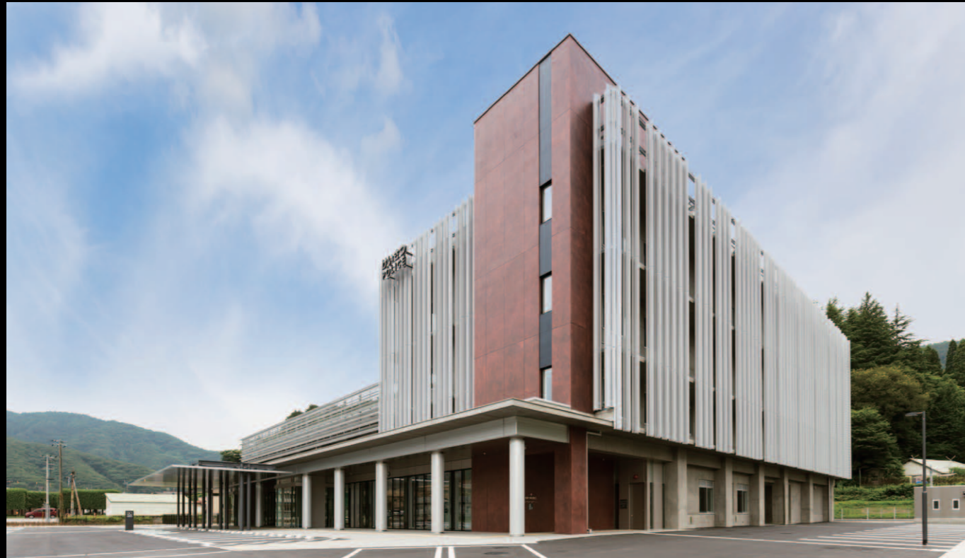
製鉄の街 釜石の庁舎外壁にコールテン鋼風塗装／釜石警察署新築工事
