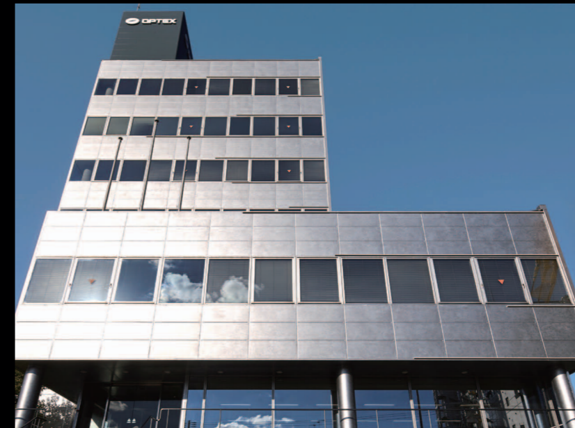
外部パネル面にリン酸処理風塗装 K-004 / 撮影 岡田大次郎
