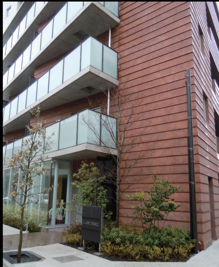
コンクリート打ち放しの上にサビ塗装 SR-012
