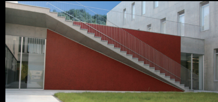
コンクリート打ち放しの上にコールドレン鋼風塗装 2
