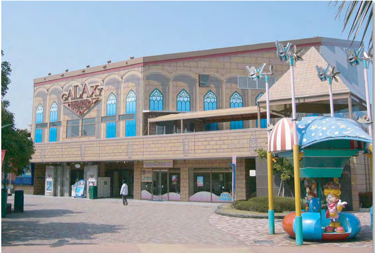
遊園地外部壁面にアーチ・窓・石目・石像の壁画
